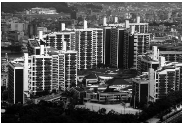
写真1 広島市宮基町高層アパート(1969～78年)。戦災復興をしめくった再開発。将来の住戸規模変更を考慮している。(2964戸)
